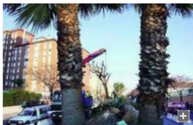
Una grúa levanta uno de los árboles afectados por el Metro, en la calle Cómpea.
